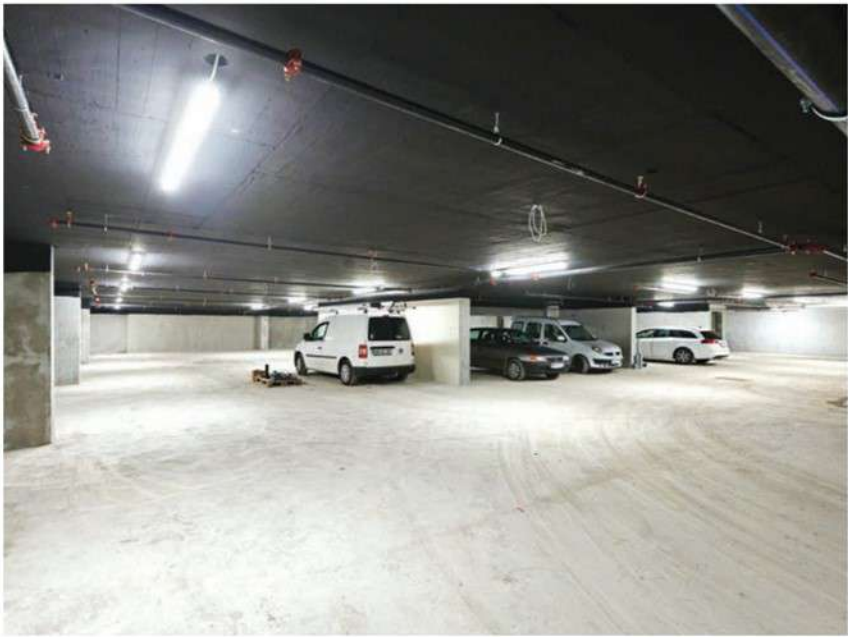
V treh etažah podzemne garaže bo 140 parkirnih mest. Foto: Andrej Petelinšek
